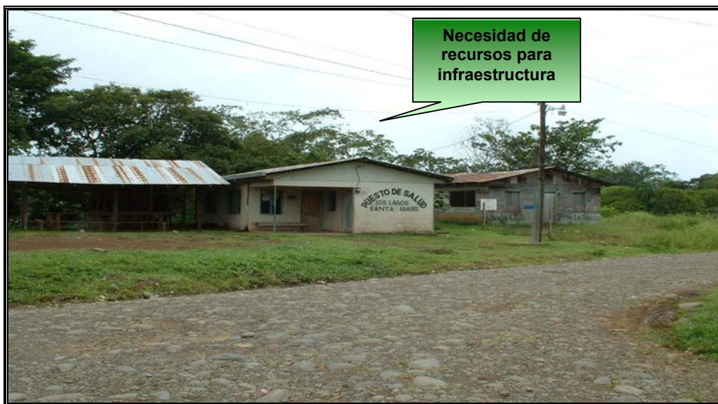
Foto 3. Puesto de Salud de Santa Isabel, Río Cuarto
