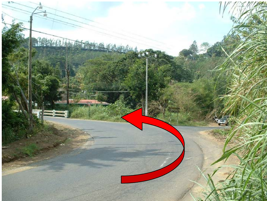
Imagen 5.: Intersección ruta Grecia - Sarchí con el camino que sale de San Juan. Nótese que el camino no es perceptible fácilmente por el conductor, por lo que puede no tomar las precauciones del caso. El señalamiento no es claro; además la curva, la vegetación y la topografía reducen la visibilidad del conductor.
