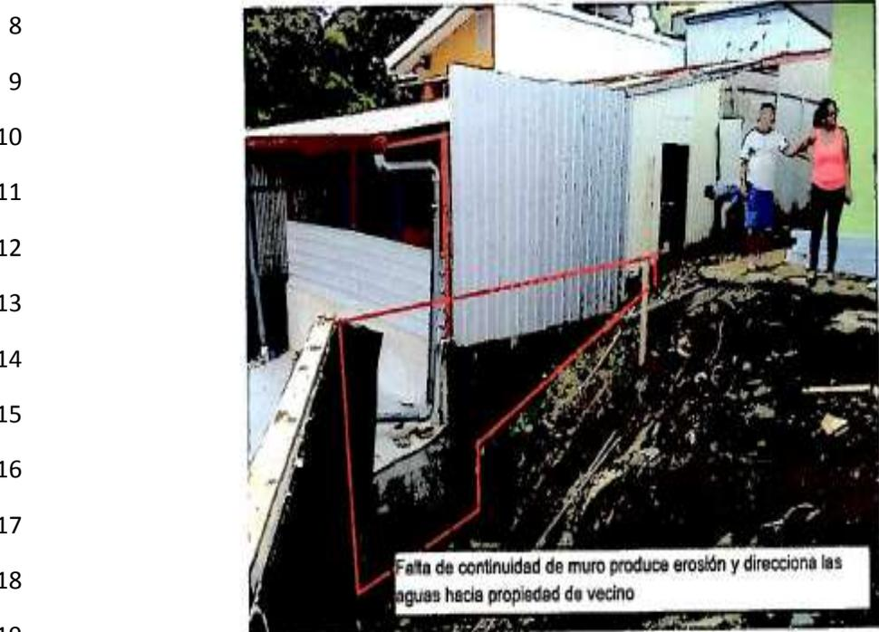
20 **Figura N. 6. Muro de retención insuficiente, faltó continuación en colindancia. Esto provoca problemas de**
