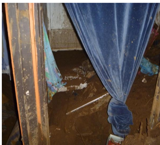
Afectación de vivienda
