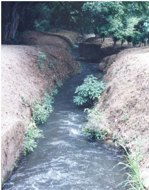
Imagen 23: Canales abiertos de Irrigación que sirven igualmente para recibir aguas de escorrentía.
