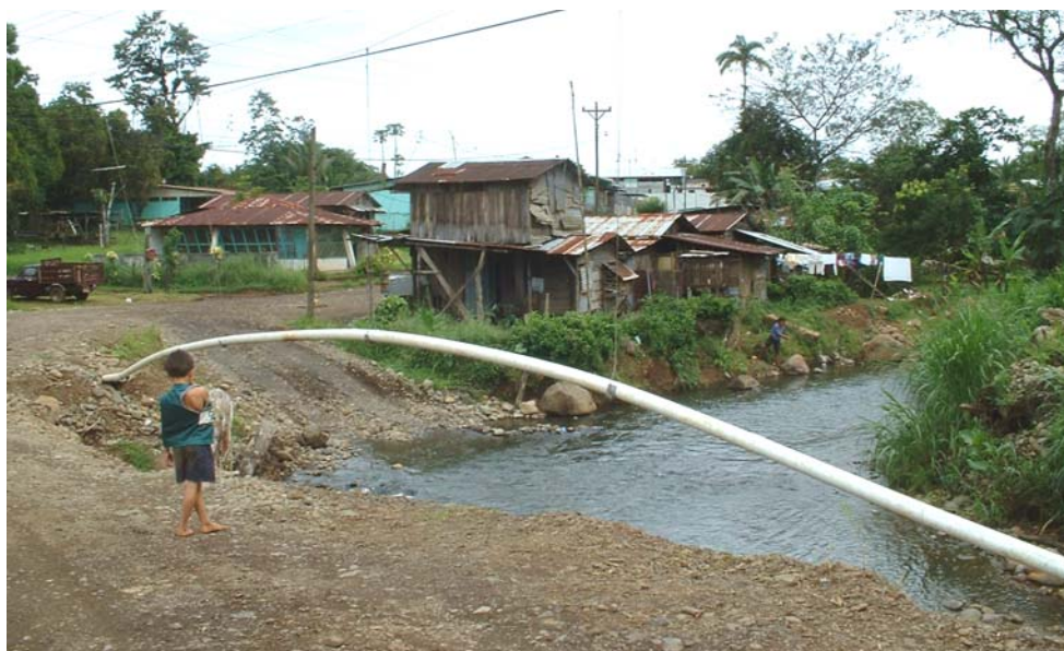
Imagen 16: Viviendas ubicadas en la zona de protección de ríos. Importante anotar el estado de las viviendas y las condiciones de sanidad en que viven estas personas. Río Cuarto
