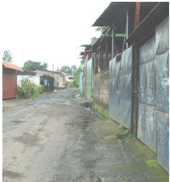
Imagen 15. Se evidencia la salida de agua residual y no de agua pluvial. Cabe también observar la ubicación del taller, lo que podría ocasionar problemas si se desea cerrar esta vía para mejorar las condiciones de infraestructura.
