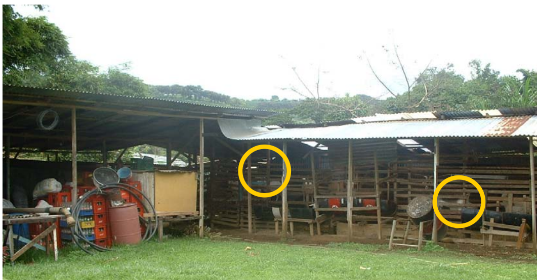
Imagen 18: Finca y Criadero de Cabras, ubicado a orillas del Río Agualote. Se observan las condiciones de la infraestructura. Al lado izquierdo, inicia el cañón del río y parte de la infraestructura se encuentra en zona de protección, a una altura y posición que hace que los desechos de las cabras caigan directamente al río.
