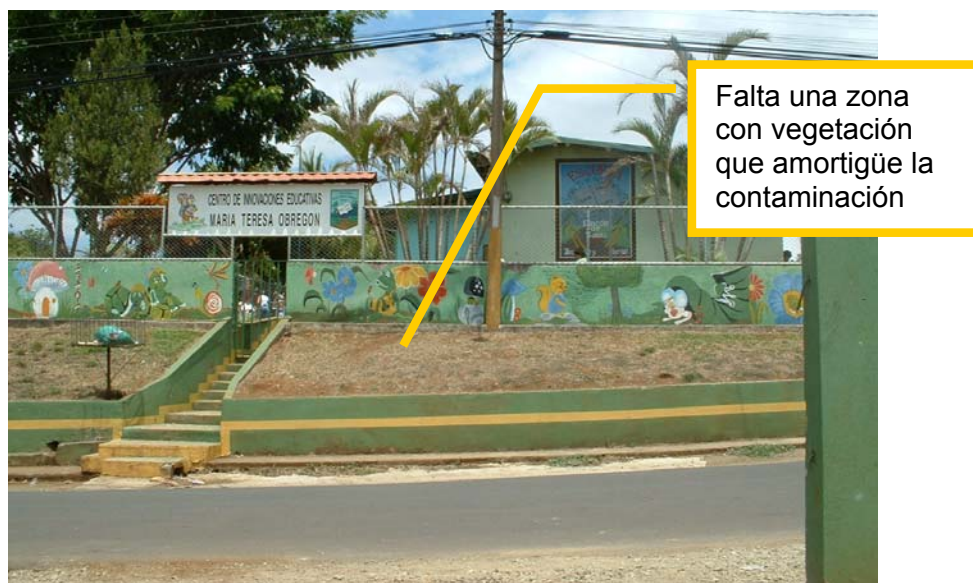
Imagen 29: Escuela ubicada muy cercana a una calle, sobre la cual se genera un tránsito importante, incluyendo maquinaria agrícola. Rincón de Salas
