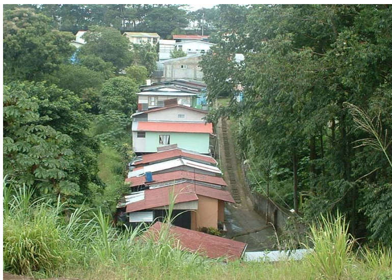
Imagen13: Viviendas construidas en terrenos no aptos, en el Sector Sur de la ciudad de Grecia, conocidas como La Alameda.
