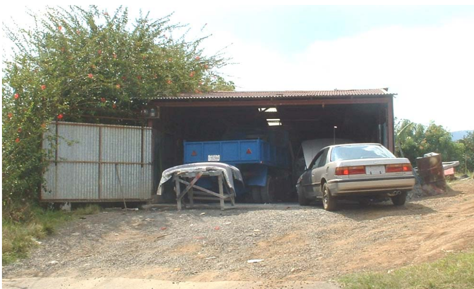
Imágenes 37 y 38: Talleres fuera del centro de Grecia, en Sueños Latino y camino hacia Los Ángeles. Obsérvese el estado de las instalaciones, y la afectación al paisaje urbano y rural de las comunidades. Además del manejo de desechos, aceites y otro.
