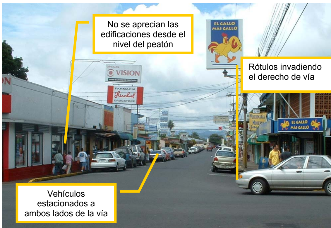
Imagen 32: En esta fotografía se aprecia la cantidad de vehículos que se estacionan a ambos lados de la vía (se contabilizaron hasta 22 en 100 metros), la cantidad de rótulos que invaden el derecho de vía y el pobre diseño urbano que genera en una escasa apreciación de las edificaciones. Faltan aceras, áreas verdes, entre otros.
