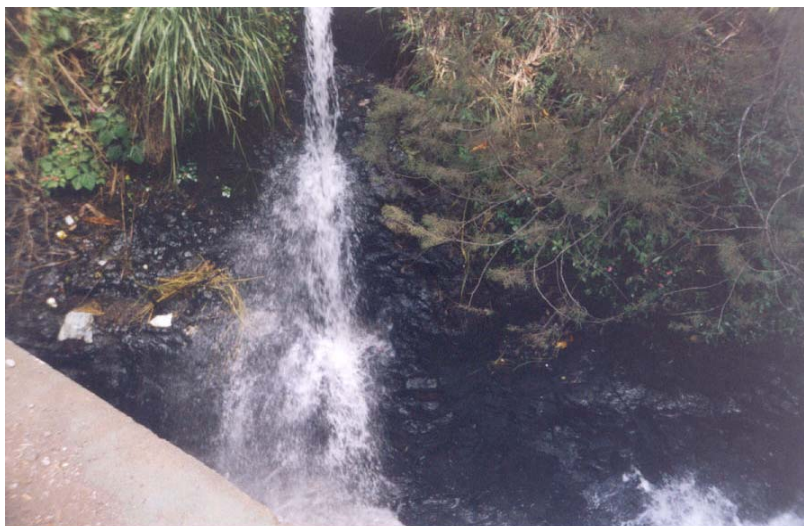
Imagen 12: Descargas directas de aguas residuales a los ríos. En este caso corresponde al Río Prendas. Debido a la falta de alcantarillados sanitarios, se presume la contaminación de los ríos en más de un sector. Además, cabe destacar que cuando se tomó la fotografía no llovía, por lo que evidencia que son aguas residuales.
