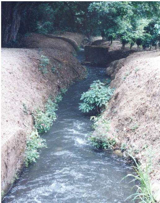
**Imagen 19: Canales abiertos de Irrigación que sirven igualmente para recibir aguas de escorrentía.**
