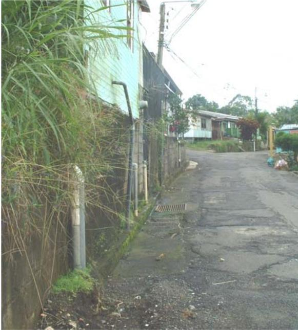
**Imagen 10: Conexiones de aguas residual a caño, ubicadas en el barrio conocido como Sector Sur.**
