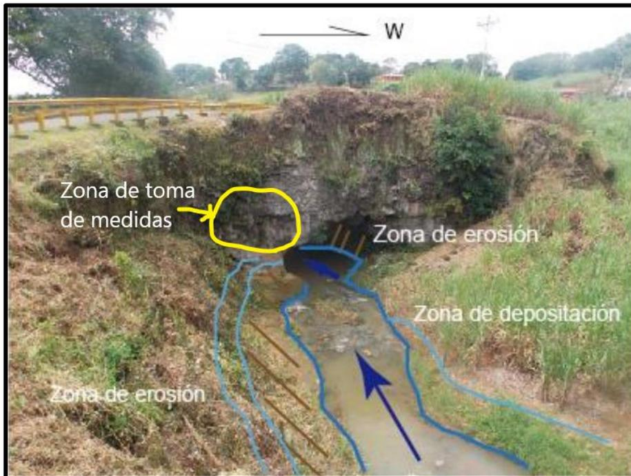
Figura 13. Zona de toma de medidas aguas arriba, junto con problemática que afecta la zona
