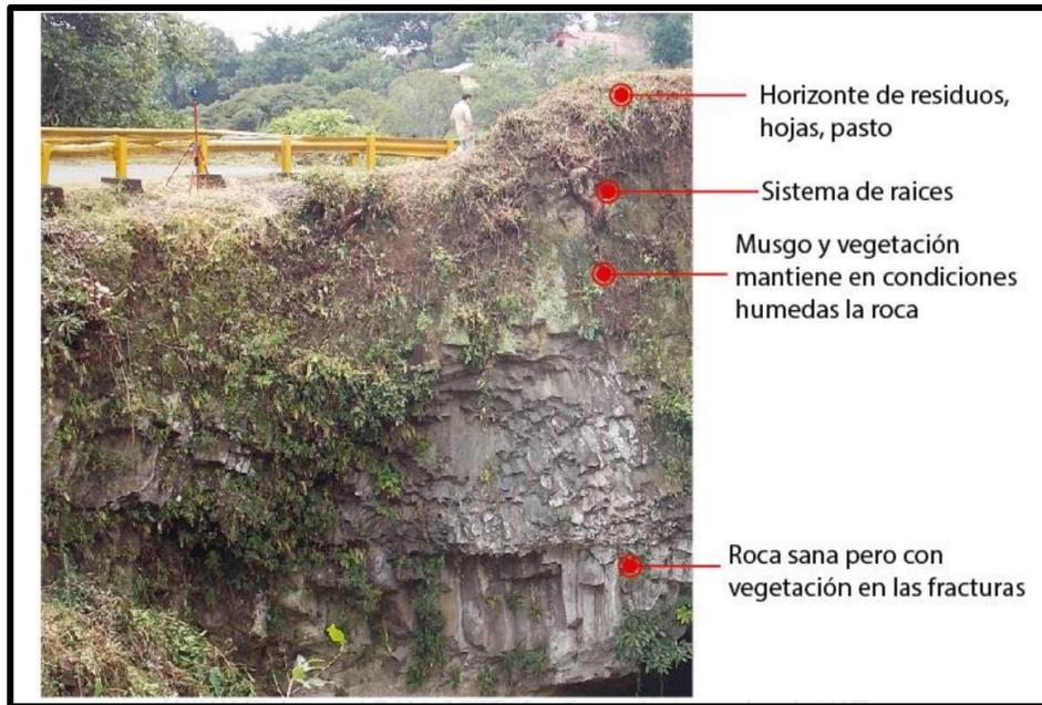
**Figura 22. Sección del puente donde se muestra como la vegetación y la generación de suelos está afectando la roca que forma el arco natural.**
