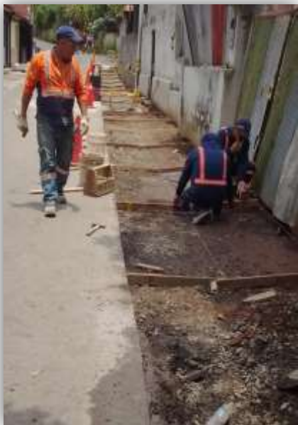
Trabajos de construcción de cajas de registro y relleno de zanja en Calle La Trinidad ₡1.884.370
