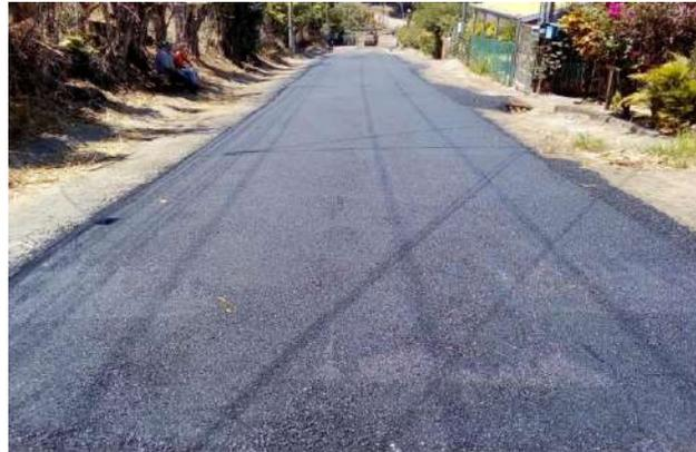
**Limpieza Mecanizada y Relastrado en la superficie de ruedo:** Además de la limpieza mecanizada en cunetas y espaldones, a la **Calle Chico Alfaro** se le aplicó la conformación y colocación de lastre sobre la superficie de ruedo.
