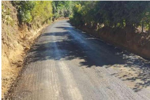
**Bacheo y mejoramiento en el sistema de drenaje:** En una sección muy deteriorada de **Calle Molina**, se realizó zanjeo, colocación de alcantarillas, construcción de cajas de registro y se colocó cordón de caño, posteriormente en ese mismo trayecto se colocó una franja de asfalto, para unir el borde del cordón de caño con la carpeta asfáltica ya existente, lo cual significa un aumento en el ancho de la superficie de ruedo.
