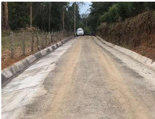
**Colocación de alcantarillas y cajas de registro:** Este trabajo consiste en la colocación de alcantarillas laterales, el alcantarillado transversal y la construcción de cajas de registro, todo como complemento al sistema de drenajes. Lo cual se realizó en **Calle Carbonal.**
