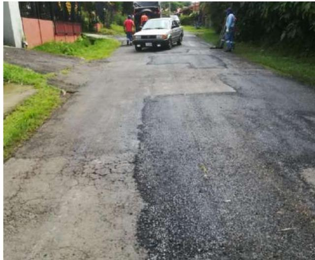
**Señalización y bacheo:** Esta fotografía en la **Urbanización la Hilda**, muestra señalización vertical horizontal, además en la misma se aprecia parte del bacheo realizado en la Calle Los Higueros.
