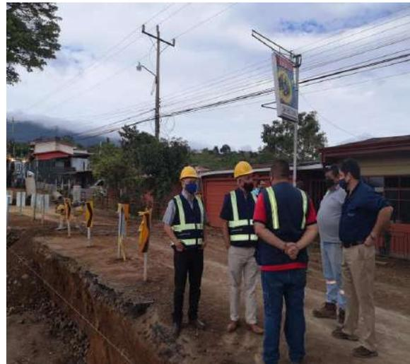
**Mejoras en los sistemas de drenaje:** Este trabajo se realizó en **Calle Llano Bonito**, en el sector de **Corinto**. Se construyó un cuneteado y colocación de parrilla, para solventar un problema con el desbordamiento de las aguas llovidas.
