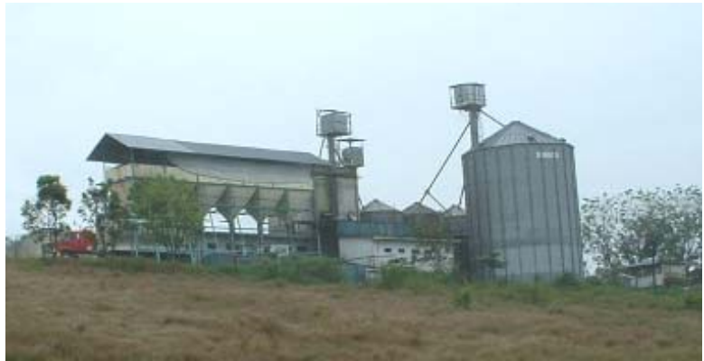
Imagen 1.4.: Instalaciones de Propokodursa.
