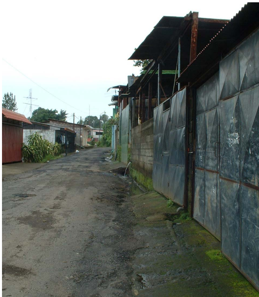
Imagen 1.9.: Sector Sur de la ciudad de Grecia, se visualiza el problema de desarrollo de calles angostas, falta de infraestructura de servicios, mal manejo de las aguas residuales y servidas. Los terrenos de a la izquierda se encuentran en pendientes fuertes, y la calle en mal estado.
